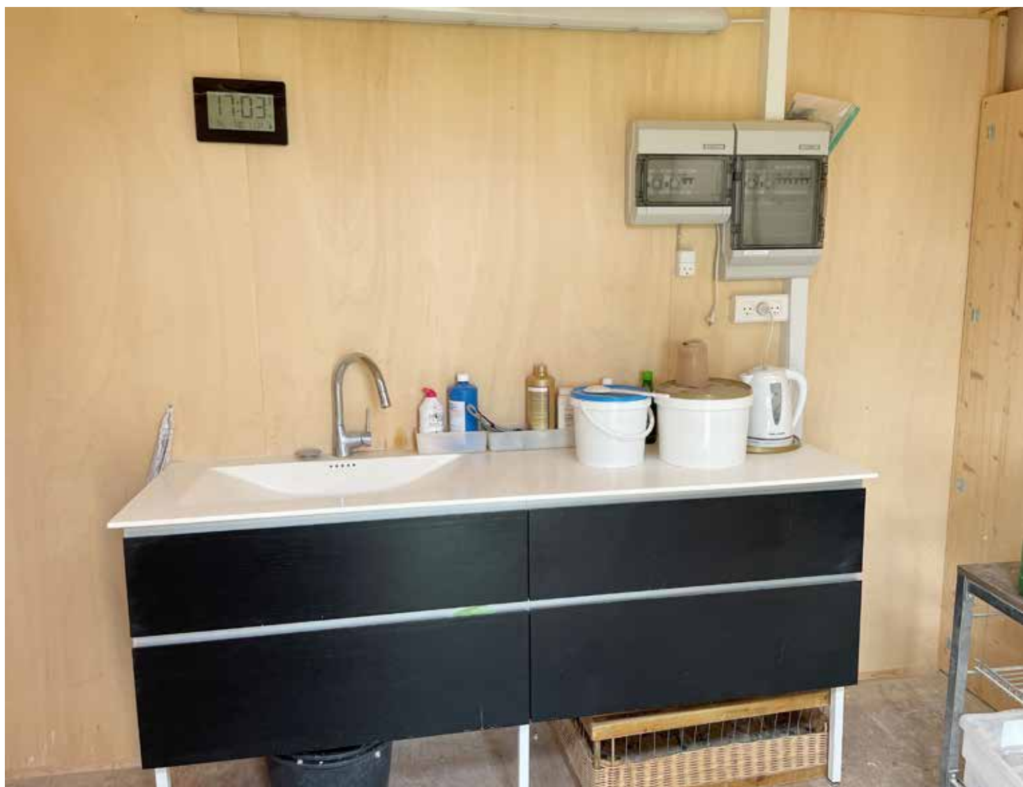
Køkken og teknikrum i slaget
