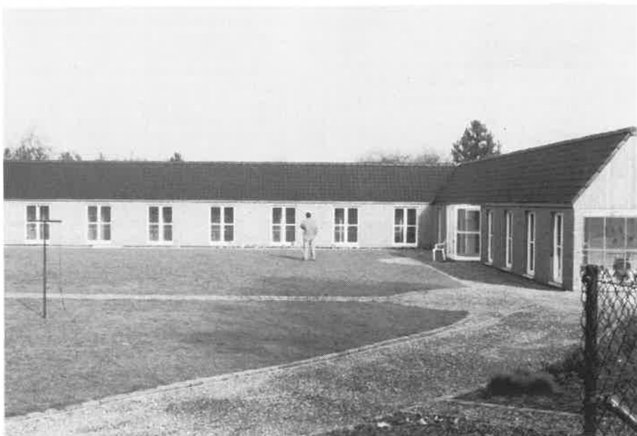
Når man nu skal bygge slag, så kan man jo lige så godt gøre det ordentlig, tænkte Jos Thoné, inden han gav sig i lag med at opføre dette slag-anlæg.
