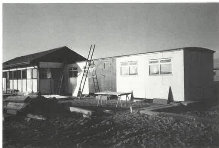
Den tilbyggede store kontorvogn under renovering.
