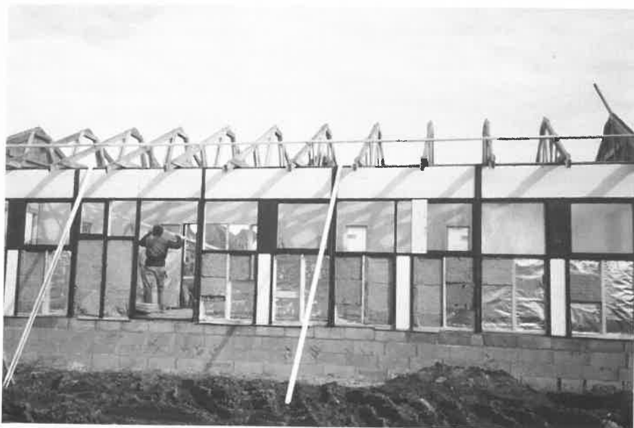
Klubhuset under genopførelse. Læg mærke til den høje sokkel.
