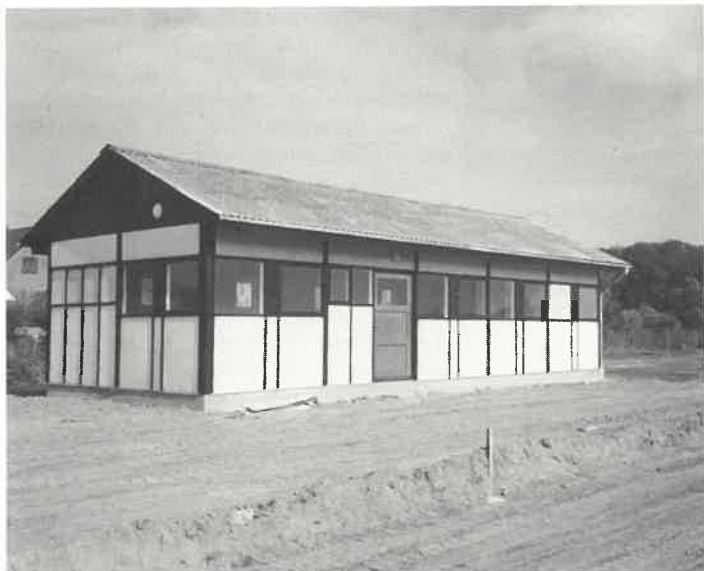
Her er klubhuset genopført i al sin ensomhed. Efter påfyldning af jord er soklen nu meget lav.
