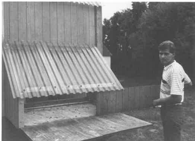
For at undgå uvelkomment besøg af katte og andre rovdyr kan ind-/udflyvningen lukkes med en skydelåge.
