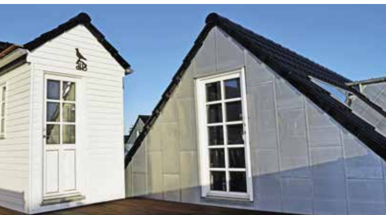
Udgang fra første sal stuehus til slag terrassen
