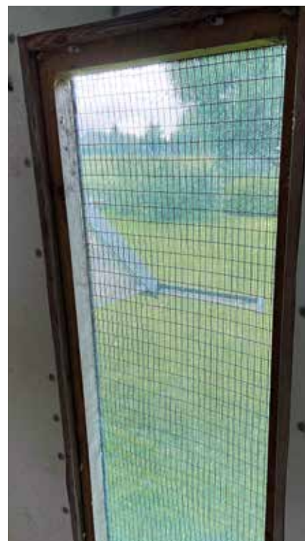
Wind-break net i vinduerne foran fodergangen
