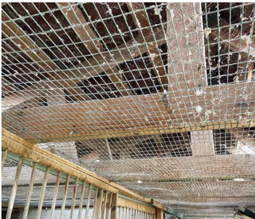
Trådvæv i loftet og et fyldigt volumen under taget der tillader korrekt ventilation
