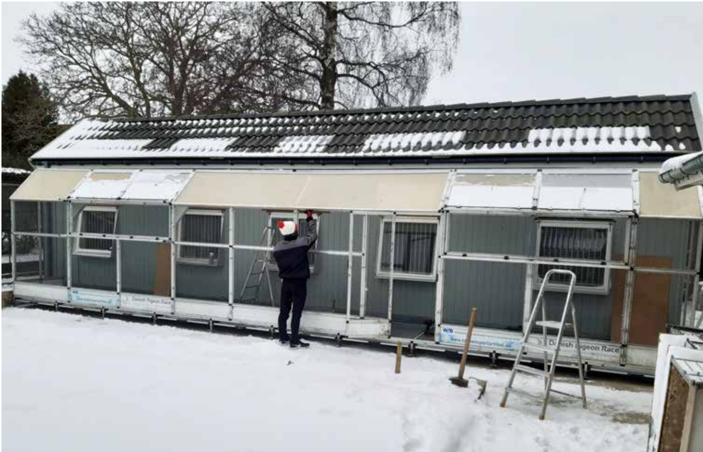
Sebastian hjælper til med byggeriet på en meget kold dag.
